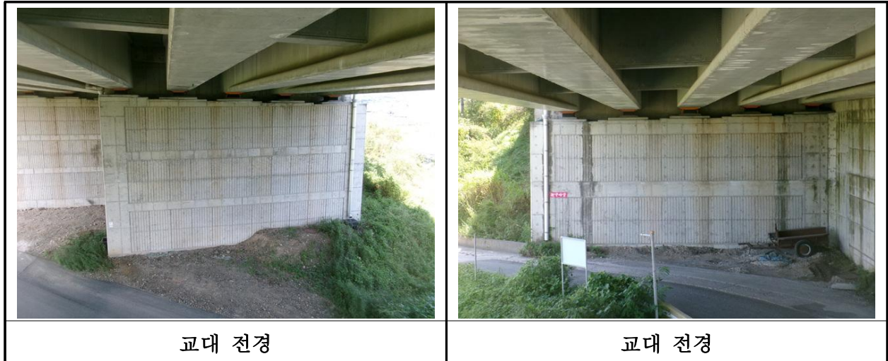
【사진 37.3.8】 교대 전경
