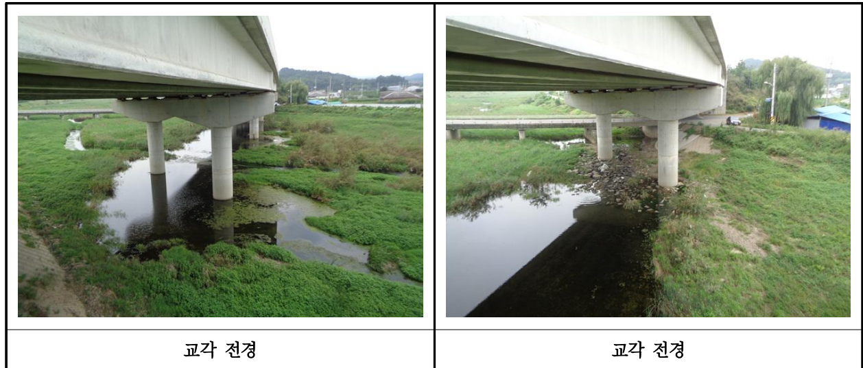
【사진 37.3.33】 교각 전경
