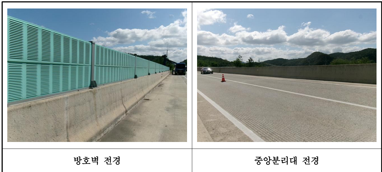
【사진 37.3.23】 방호벽 및 중앙분리대 전경
