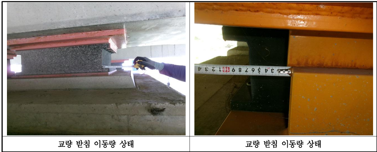
【사진 37.3.15】 교량받침 이동량 측정
