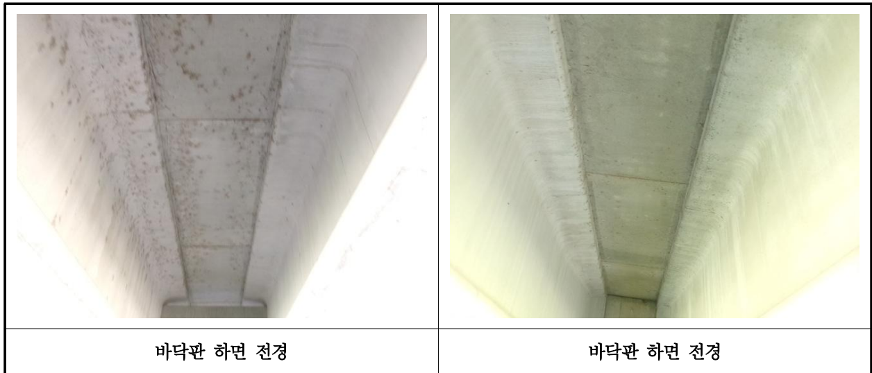
【사진 37.3.2】 바닥판하면 전경
