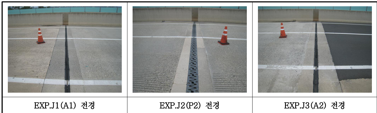
【사진 37.3.39】 신축이음장치 전경
