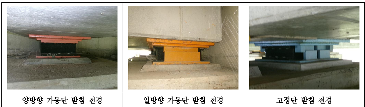
【사진 37.3.35】 교량반침 전경
