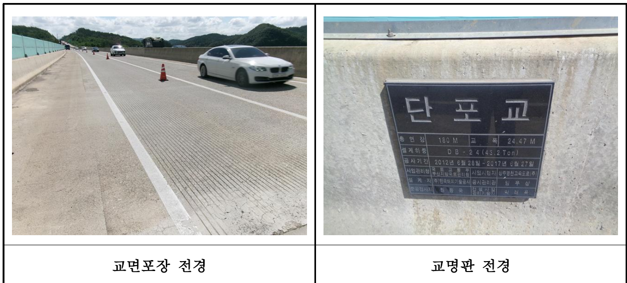
【사진 37.3.19】 교면포장 전경
