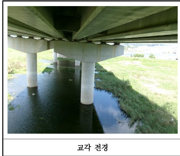
【사진 37.3.10】 교각 전경
