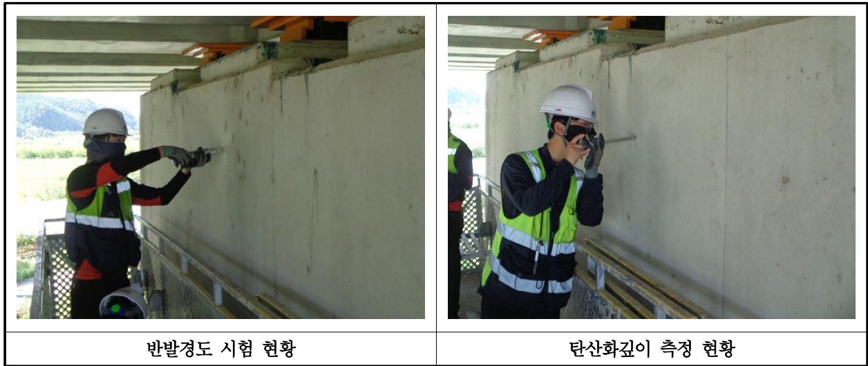
【사진 37.4.1】 콘크리트 내구성조사 현황
