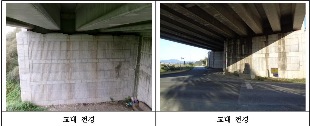
【사진 37.3.31】 교대 전경
