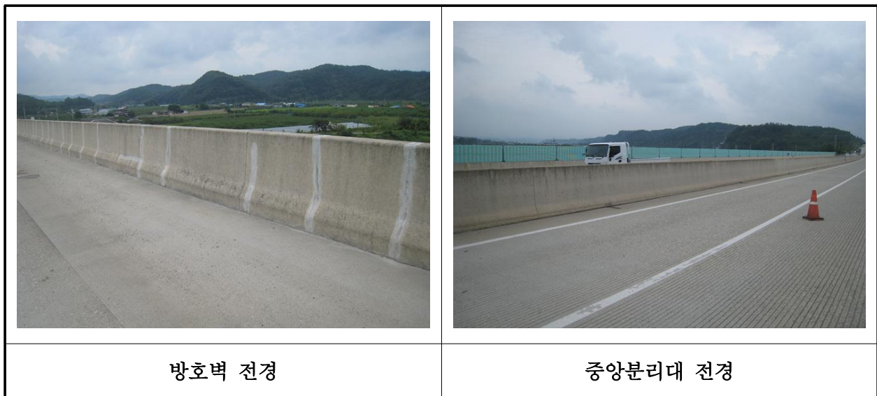
【사진 37.3.46】 방호벽 및 중앙분리대 전경
