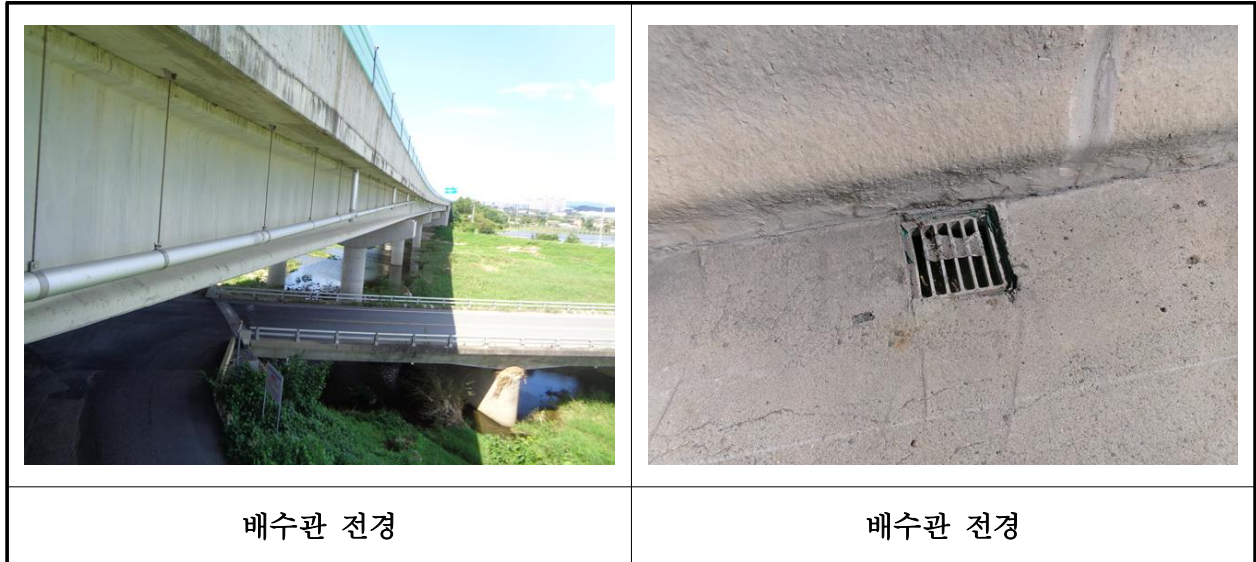
【사진 37.3.21】 배수시설 전경
