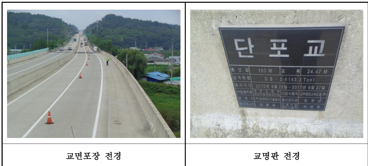
【사진 37.3.42】 교면포장 전경
