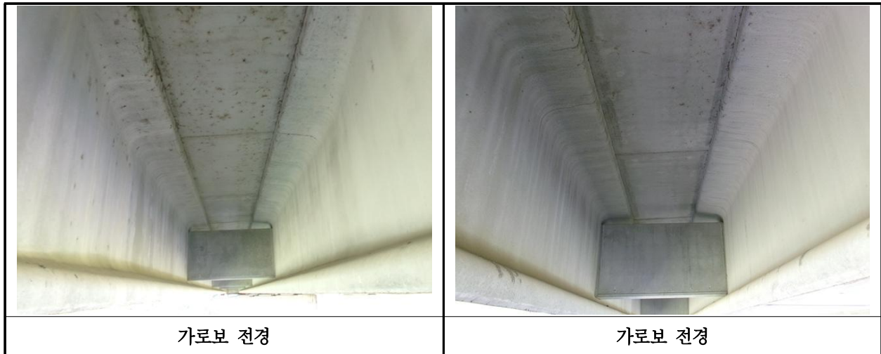
【사진 37.3.6】 가로보 전경
